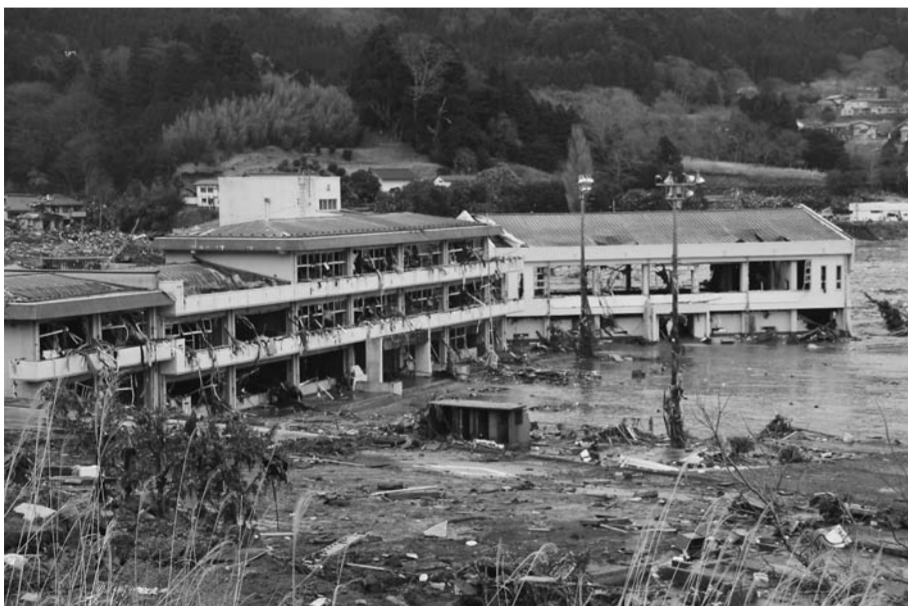
校舎3階まで波に破られ、体育館もうつろとなった越喜来小＝三陸町
