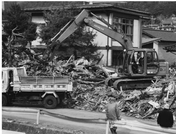
市内各地で本格化したがれき撤去＝大船渡町
